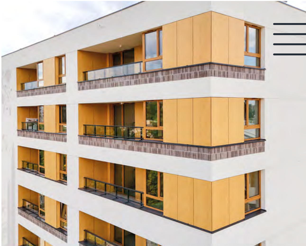
material used / matériau utilisé / verwendetes material: BOLIX SI-SIT
